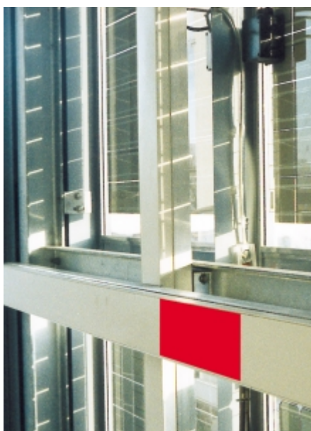
Abbildung 4: Matrixinstallation mit modulatorientiertem Stromrichter (hier RIC - Room-In-Converter)
